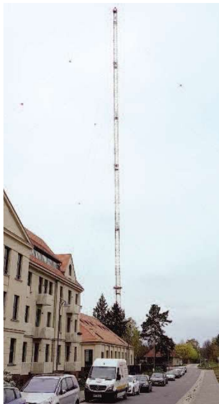
Bild 2: Der Funkerberg: Außenansicht des Sendemastes
