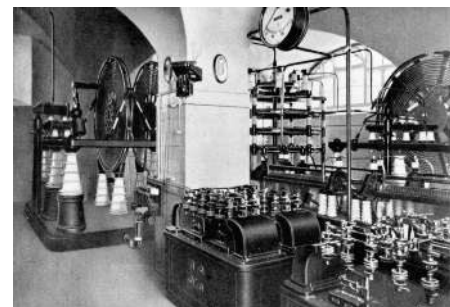
Bild 9: Senderraum mit Spulen der 70-kW-Station Königs Wusterhausen 1916 [8]. Spulen für Sender hoher Leistung wurden aus versilbertem Kupferrohr von bis zu 5 Zentimeter Durchmesser gewickelt.
