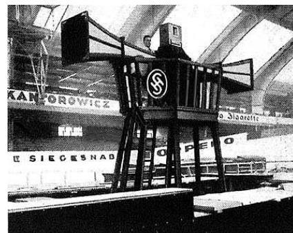
Grosslautsprecheranlage für Werbezwecke (Berlin) 1924. Auf die Betriebssicherheit des Bandlautsprechers war jedoch kein Verlass, sodass während des Betriebes immer ein Techniker mit einem Ersatzbändchen in der Nähe sein musste.
