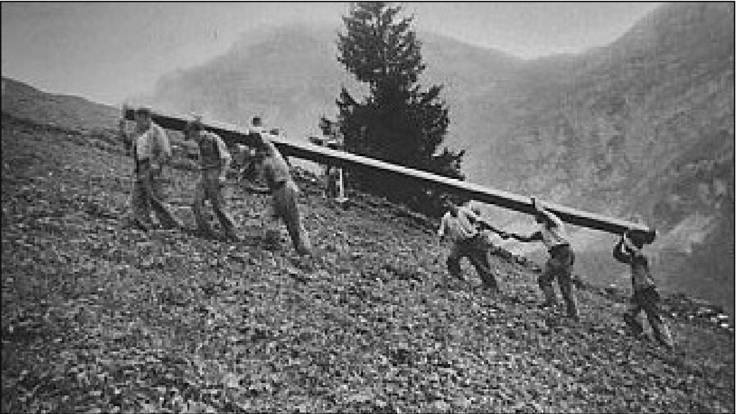
*Graben, sprengen und acht Meter lange Röhren bergauf tragen.*
